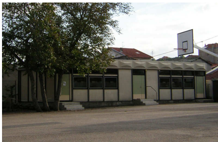
Un bâtiment annexe distant d'une cinquantaine de mètres également couvert en CPL.
